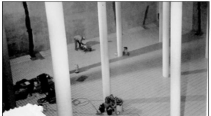
Blick in die riesige Behälterkammer 2, die Rissanierungen sind deutlich zu erkennen. Der Wasserverlust belief sich auf ca. 28 m<sup>3</sup> pro Tag.
