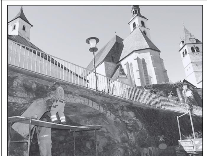
Die ruhigere Zeit in der Zwischensaison wird immer wieder genutzt, um im Bereich des öffentlichen Gutes Sanierungsarbeiten durchzuführen. Im Bild zu sehen sind die Maurer des städtischen Bauhofes bei Ausbesserungsarbeiten an der Unterführung in der Gänsbachgasse. Diese zumeist „unspektakulären“ Arbeiten sind ein wichtiger Beitrag für ein sehenswertes Ortsbild.
